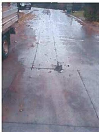
**Figura 6.** - Corte do betuminoso ao longo da extensão do coletor
